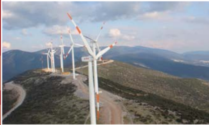
Akbük Rüzgar Enerjisi Santrali , Aydın İli Didim İlçesinde ve kurulu gücü 31,5 MW, yıllık üretim kapasitesi 122 milyon kWh'dir.
