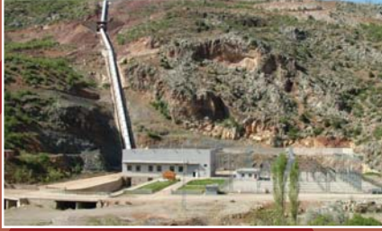
Çamlıca I HES , Kayseri İli Yahyalı İlçesinde bulunmakta olup kurulu gücü 84 MW, yıllık üretim miktarı 429 milyon kWh'dir.
