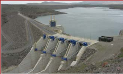
Yamula Barajı ve HES , Kayseri İli, Kızılırmak Nehri üzerinde bulunmaktadır ve kurulu gücü 100 MW, yıllık üretim kapasitesi 423 milyon kWh'dir.
